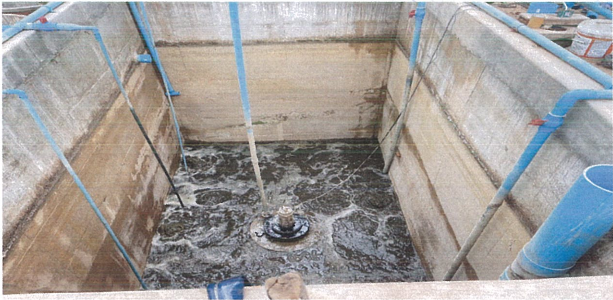
ภาพออกตรวจระบบบำบัดน้ำเสีย ปีงบประมาณ ๒๕๖๖
